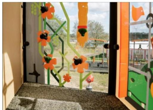
Высококачественный поликарбонат толщиной 15 мм. Графическая печать добавляется уникальным процессом многослойной печати, где внутренний слой является изображением, а внешний прозрачный слой выполняет функцию защиты. Панель ПК и лак на водной основе устойчивы к ультрафиолетовому излучению для предотвращения выцветания.
