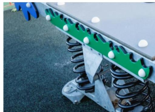
Использование двух пружин и центрального переломного момента позволяет пользователям разных возрастов играть вместе. Втулка переломного момента изготовлена из высококачественного нейлона (PA6).
