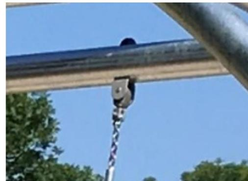
Уникально разработанные подвески из нержавеющей стали с функцией анти-скручивания. Подвески крепятся к поперечной балке с помощью болтового соединения для обеспечения высокой прочности.
