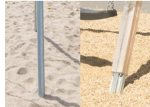
Опора качелей А-образной рамы доступна для закрепления на поверхности с помощью дюбелей или заглубления на глубине 60 или 90 см. Стальные опоры из оцинкованной стали закреплены непосредственно в земле. Столбы из сосны подняты над землей уникальным профилированным основанием из оцинкованной стали.
