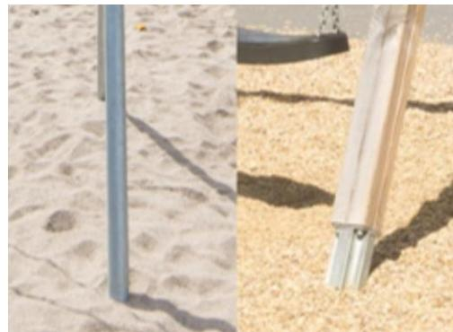
Опора качелей A-образной рамы доступна для закрепления на поверхности с помощью дюбелей или заглабления на глубине 60 или 90 см. Стальные опоры из оцинкованной стали закреплены непосредственно в земле. Столбы из сосны подняты над землей уникальным профилированным основанием из оцинкованной стали.
