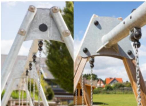
A-образная рама оснащена ригелем горячего цинкования диаметром 100 мм с крупными стальными концевыми пластинами для прочной фиксации двух опор: сталь горячего цинкования диаметром 70 мм. Пропитанная древесина сосны с опорами из оцинкованной стали.
