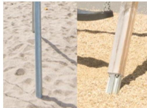
Опора качелей A-образной рамы доступна для закрепления на поверхности с помощью дюбелей или заглубления на глубине 60 или 90 см. Стальные опоры из оцинкованной стали закреплены непосредственно в земле. Столбы из сосны подняты над землей уникальным профилированным основанием из оцинкованной стали.
