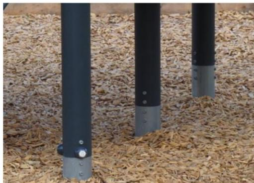
Основные стойки с опорами из горячепогруженно оцинкованной стали доступны в различных материалах: пропитанные под давлением стойки из сосновой древесины, предварительно оцинкованные внутри и снаружи стальные стойки с порошковым покрытием или алюминиевые стойки без свинца с цветной анодированной верхней отделкой.
