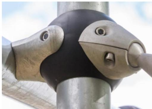
Соединительный шар GALAXY уникальной конструкции выполнен с внутренним круглым алюминиевым сердечником, окруженным оболочкой из твердого полипропилена с наружным слоем из мягкой резины TPV. Гибкие бессвинцовые алюминиевые соединители позволяют устанавливать их под разными углами.
