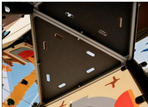
Все палубы поддерживаются уникальными алюминиевыми профилями с несколькими вариантами крепления благодаря использованию литых алюминиевых соединителей. Палубы HPL толщиной 17,8 мм с очень высокой износостойкостью и уникальной нескользящей текстурой поверхности от KOMPAN.
