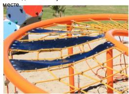
Мембраны Corocord состоят из износостойкого прорезиненного материала конвейерного качества с отличной стойкостью к ультрафиолетовому излучению. Протестировано и соответствует требованиям REACH для ЛАГ. Закладка представляет собой четырехслойную броню из тканого полиэстера. В результате армирования и двух поверхностных слоев общая толи составляет 7,5 мм.
