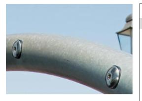
Стальная конструкция оцинкована методом горячего цинкования внутри и снаружи без содержания свинца. Гальванизация обладает отличной устойчивостью к коррозии во внешних средах и требует низких эксплуатационных расходов.
