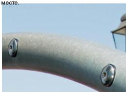
Стальная конструкция оцинкована методом горячего цинкования внутри и снаружи без содержания свинца. Гальванизация обладает отличной устойчивостью к коррозии во внешних средах и требует низких эксплуатационных расходов.
