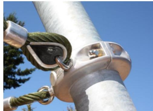
Алюминиевые зажимы Corocord используются в качестве соединителей между стальными опорами и тросом. Две алюминиевые отливки скреплены болтами. Высота зажимов, таким образом, является переменной.
