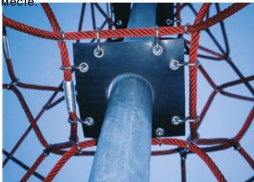
Мембраны Corogcord состоят из износостойкого прорезиненного материала конвейерного качества с отличной стойкостью к ультрафиолетовому излучению. Протестировано и соответствует требованиям REACH для ЛАГ. Закладка представляет собой четырехслойную броню из тканого полиэстера. В результате армирования и двух поверхностных слоев общая толщина составляет 7,5 мм.
