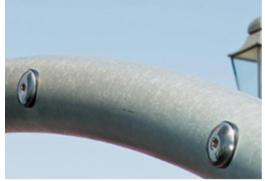
Стальная конструкция оцинкована методом горячего цинкования внутри и снаружи без содержания свинца. Гальванизация обладает отличной устойчивостью к коррозии во внешних средах и требует низких эксплуатационных расходов.
