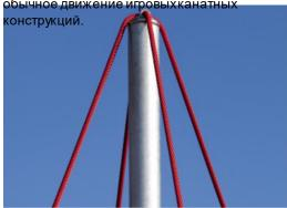
В центре сетки находится мачта, изготовленная из высококачественной бесшовной стали. Структура мачты как колеблющейся опоры является статически выгодной, уравновешивая колебания в сети. Стандартно мачты оцинкованы горячим способом с возможностью дополнительного нанесения порошкового покрытия.
