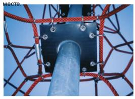
Мембраны Corocord состоят из износостойкого прорезиненного материала конвейерного качества с отличной стойкостью к ультрафиолетовому излучению. Протестировано и соответствует требованиям REACH для ЛАГ. Закладка представляет собой четырехслойную броню из тканого полиэстера. В результате армирования и двух поверхностных слоев общая толщина составляет 7,5 мм.
