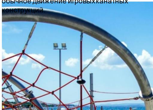
Стальные арки горячей оцинковки внутри и снаружи. Гальванизация обладает отличной устойчивостью к коррозии во внешних средах и требует низких эксплуатационных расходов.
