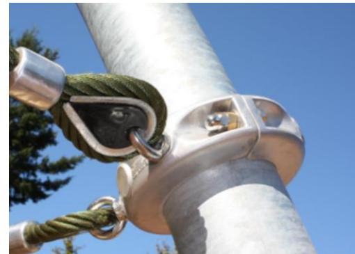
Алюминиевые зажимы Corocord используются в качестве соединителей между стальными опорами и тросом. Две алюминиевые отливки скреплены болтами. Высота зажимов, таким образом, является переменной.
