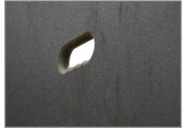
Поверхность стены изготовлена из ламината высокого давления толщиной 17,8 мм (HPL) для обеспечения оптимальной прочности и долговечности.
