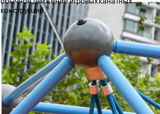
Металлические детали изготовлены из высококачественной стали, оцинкованной методом горячего цинкования внутри и снаружи без содержания свинца. Более того, на поверхность нанесен дополнительный слой порошкового покрытия. Это обеспечивает как отличную устойчивость к коррозии, так и ярко выраженный дизайн.
