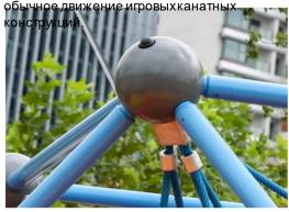
Металлические детали изготовлены из высококачественной стали, оцинкованой методом горячего цинкования внутри и снаружи без содержания свинца. Более того, на поверхность нанесен дополнительный слой порошкового покрытия. Это обеспечивает как отличную устойчивость к коррозии, так и ярко выраженный дизайн.
