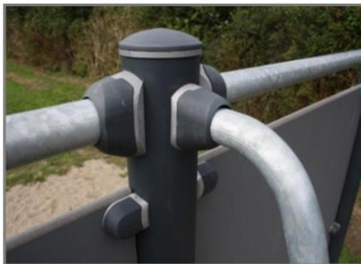
Разъемы изготовлены из литого под давлением алюминия, специально легированного для наружных условий и интенсивного использования. Виты крепления разъемов выполнены из нержавеющей стали и защищены цинковыми шайбами.
