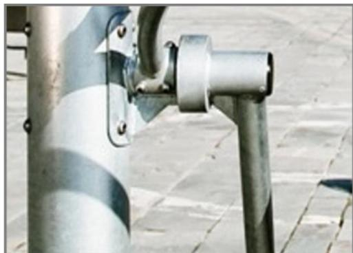
Рукоятка и маятниковый кронштейн изготовлены из стальной оцинкованной трубы толщиной 48 мм с толщиной стенки 3,2 мм. Сильная связь, которая необходима, чтобы противостоять силам, созданным во время этого движения.
