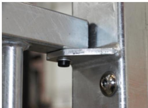
Все стальные компоненты изготовлены из углеродистой стали, сварка в соответствии с EN ISO 5817 и горячего цинкования (HDG) в соответствии с ISO1461. Этот процесс обеспечивает хорошую защиту при любых обстоятельствах.
