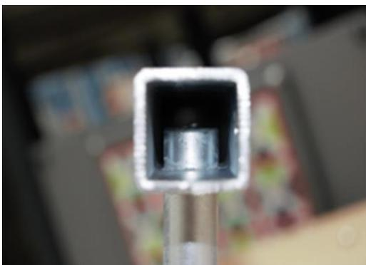
Трубы размером 21,3 мм x 2 мм встроены в стальную панель, что позволяет избежать образование трещин и предотвращает пробивание труб из стальной рамы. Это создает чрезвычайно крепкое и защищенное от вандализма решение.
