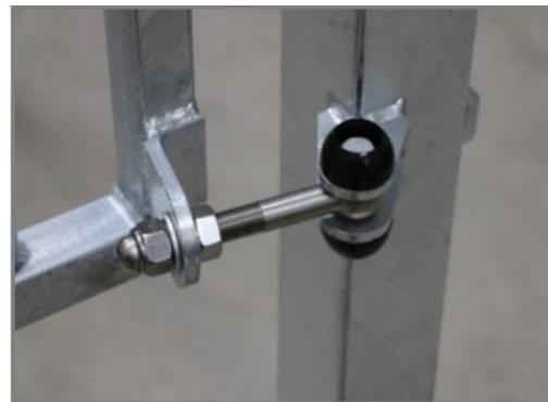
16 мм петли на входных воротах изготовлены из нержавеющей стали. Доступ к ручке возможен как изнутри, так и снаружи поля, но сконструирован таким образом, что ручка остается полностью плоской с внутренней стороны MUGA.
