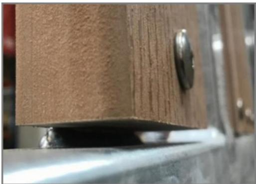
Древесно-пластиковые композитные панели изготовлены из 100% переработанного волокна/древесного порошка и полиэтилена высокой плотности (HDPE). Панели размером 860x110x30 мм чрезвычайно прочные.
