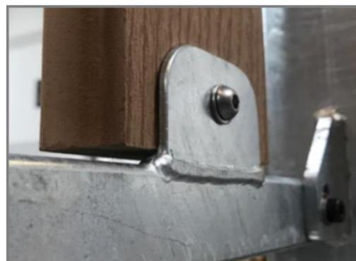
Древесно-пластиковые композитные панели крепятся к сварным фланцам размером 70 x 45 x 3 мм с помощью болтов М8 из нержавеющей стали, гаек и шайб. Эти соединения не видны изнутри и создают прочное и безопасное соединение.
