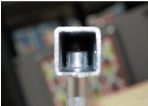
Трубы размером 21,3 мм x 2 мм встроены в стальную панель, что позволяет избежать образование трещин и предотвращает пробивание труб из стальной рамы. Это создает чрезвычайно крепкое и защищенное от вандализма решение.
