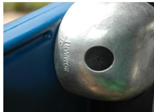
Панели и игровые элементы крепятся к опорам с помощью бессвинцовых алюминиевых разъемов, отлитых под давлением, с герметичными головками болтов. Разъемы крепятся к стойке с помощью ремня из нержавеющей стали и затягиваются стальными болтами Loctite.
