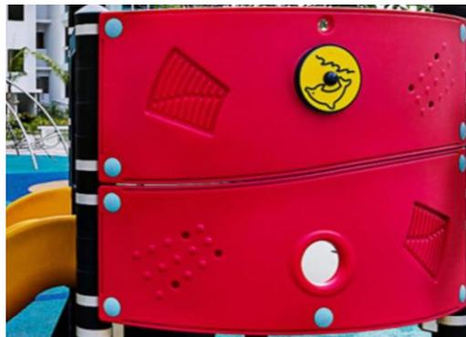
Изогнутые и прямые панели изготовлены из УФ-стабилизированного полиэтилена. Панели имеют несколько встроенных игровых функций, что также обеспечивает надежное решение для панели. Другие панели изготовлены из 19мм PE EсоCore™ от KOMPAN, который является очень прочным, экологичным и пригодным для вторичной переработки материалом.
