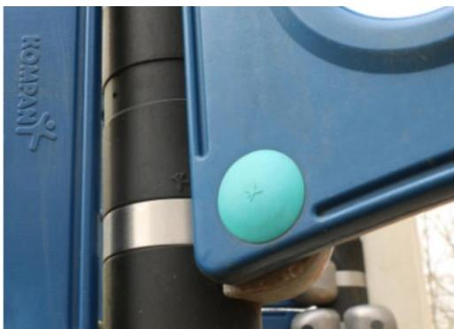
Основные опоры, представляющие собой 4-дюймовые предварительно оцинкованные с наружи и внутри стальные трубы с наружным слоем из полиуретановой резины толщиной 3 мм. Резина PUR отливается непосредственно на стальную трубу для обеспечения идеальной адгезии для длительного срока службы в любых климатических условиях.
