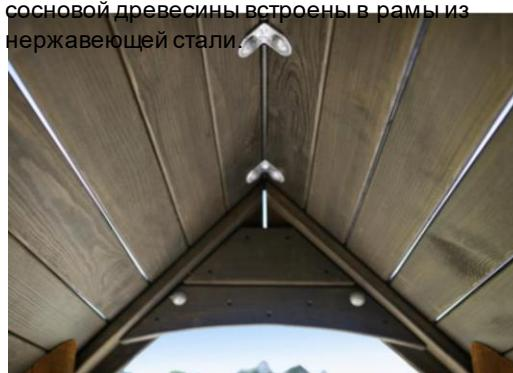
Крыша изготовлена из пропитанной и окрашенной в коричневый цвет сосновой древесины. Это обеспечивает долговечность изделия и хороший внешний вид древесины на долгие годы.
