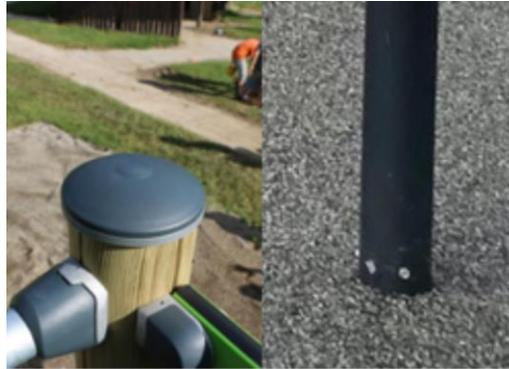
Основные стойки с опорами из горячо-погруженно оцинкованной стали доступны в различных материалах: пропитанные под давлением стойки из сосновой древесины, предварительно оцинкованные внутри и снаружи стальные стойки с порошковым покрытием или алюминиевые стойки без свинца с цветной анодированной верхней отделкой.
