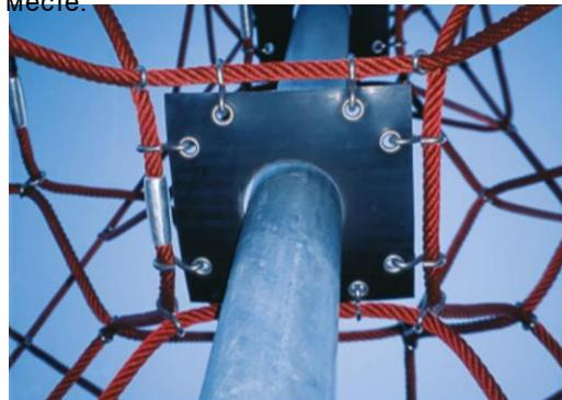
Мембранные Corocord состоят из износостойкого прорезиненного материала конвейерного качества с отличной стойкостью к ультрафиолетовому излучению. Протестировано и соответствует требованиям REACH для ЛАГ. Закладка представляет собой четырехслойную броню из тканого полиэстера. В результате армирования и двух поверхностных слоев общая толщина составляет 7,5 мм.
