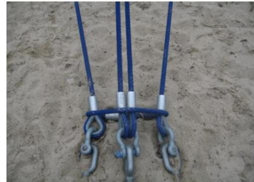
Огромные структуры космической сети прикреплены к фундаменту с помощью системы трех фаркопов. Горизонтальные и вертикальные кромочные кабели крепятся к отдельным стяжкам, которые затем соединяются отдельными стальными анкерами. Эта система гарантирует, что каждый крайний кабель может быть натянут отдельно, повышая безопасность конструкции благодаря независимой
