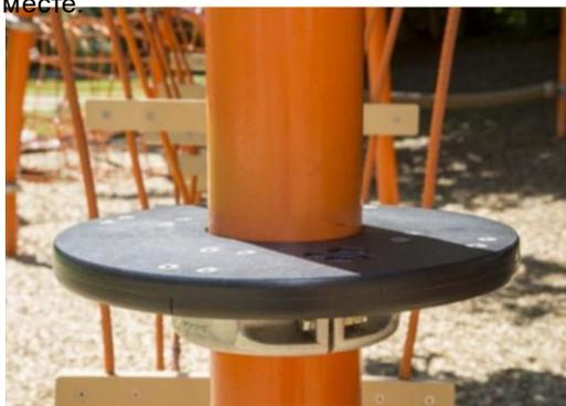
Диски изготовлены из высокопрочного, экологически чистого HDPE, который не только подлежит вторичной переработке после использования, но также состоит из сердечника, изготовленного из 100% переработанного материала.
