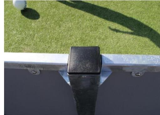
Опоры изготовлены из профиля 80x80x3 мм с горизонтально сварными 6 мм фланцами. Это позволяет легкую установку и прочную конструкцию. Заглушки из полиэтилена низкой плотности крепятся глухими заклепками.
